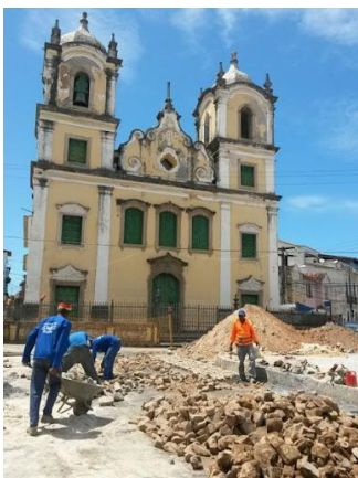
Foto 1: Intervenção recente do Gov. Estado, elevando a área central do Largo da Saúde.
